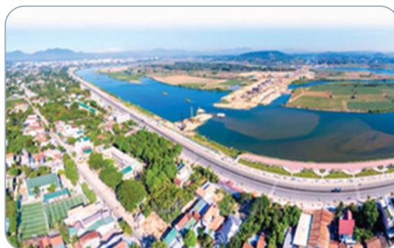
Hình 1.13. Hạ tầng đô thị thành phố Quảng Ngãi
